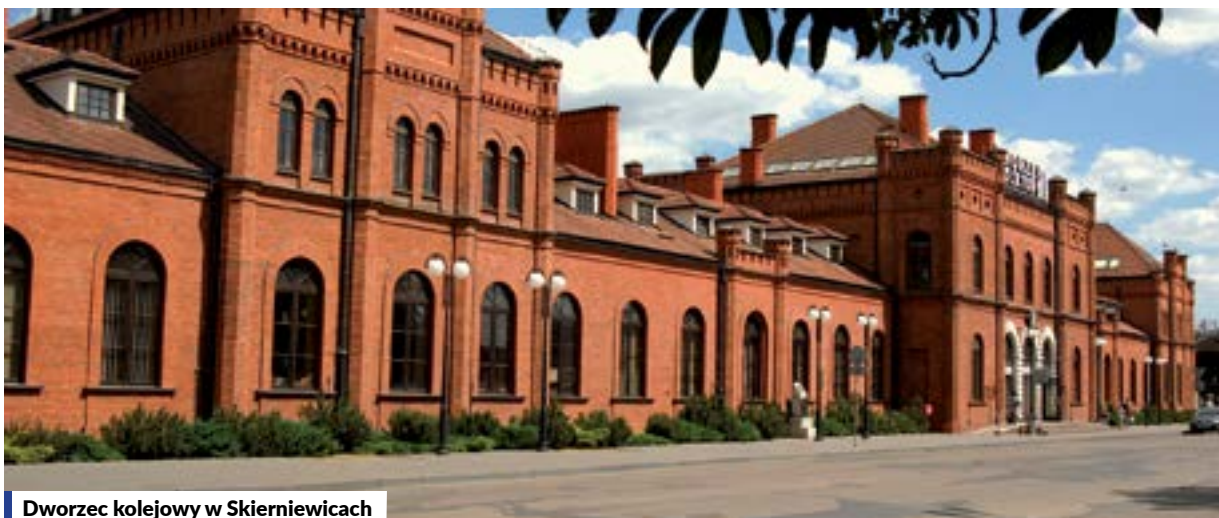
Dworzec kolejowy w Skierniewicach
