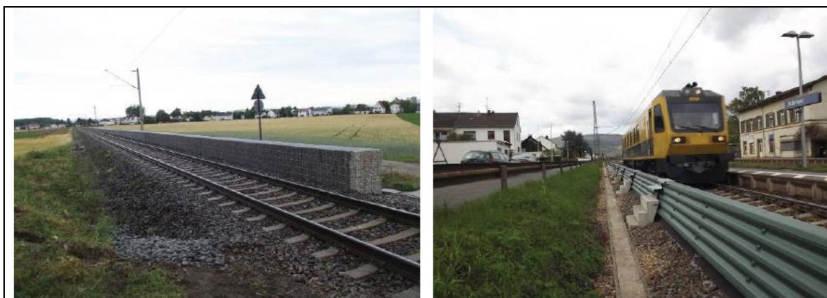
Rys. 18 Niski ekran przeciwhałasowy (wysokość 0,75 m) (źródło: DB Netze: Innovative Maßnahmen zum Lärm- und Erschütterungsschutz am Fahrweg, Schlussbericht, 2012)
