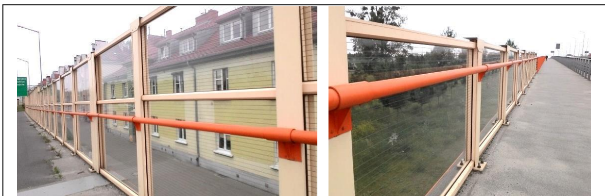
Rys. 15 Przejrzysty ekran przeciwhałasowy odbijający o lekkiej konstrukcji na wiadukcie (materiały własne)
