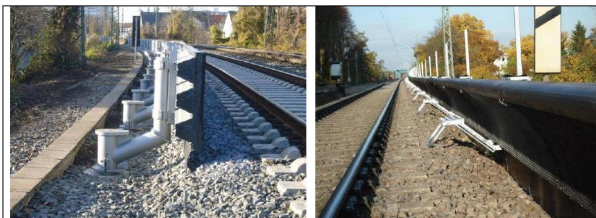
Rys. 19 Niski ekran przeciwhałasowy, nieodchylany (źródło: DB Netze: Innovative Maßnahmen zum Lärm- und Erschütterungsschutz am Fahrweg, Schlussbericht, 2012)
