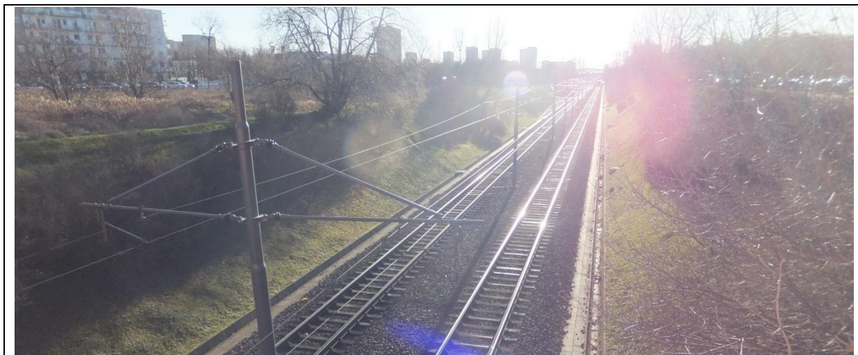
Rys. 21 Wały ziemne wzdłuż linii tramwajowej; torowisko zlokalizowane jest poniżej poziomu terenu na którym znajduje się zabudowa mieszkaniowa (materiały własne)
