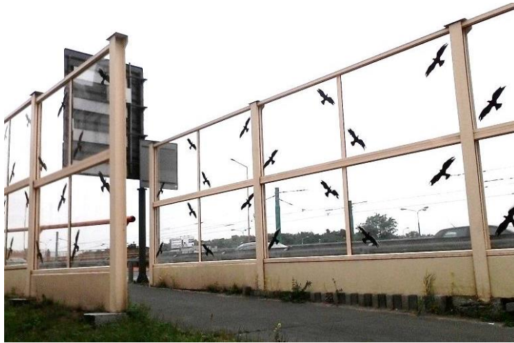
Rys. 13 Przejrzyste ekrany przeciwhałasowe odbijające (na zakładkę) w pobliżu zabudowy mieszkaniowej (materiały własne)
