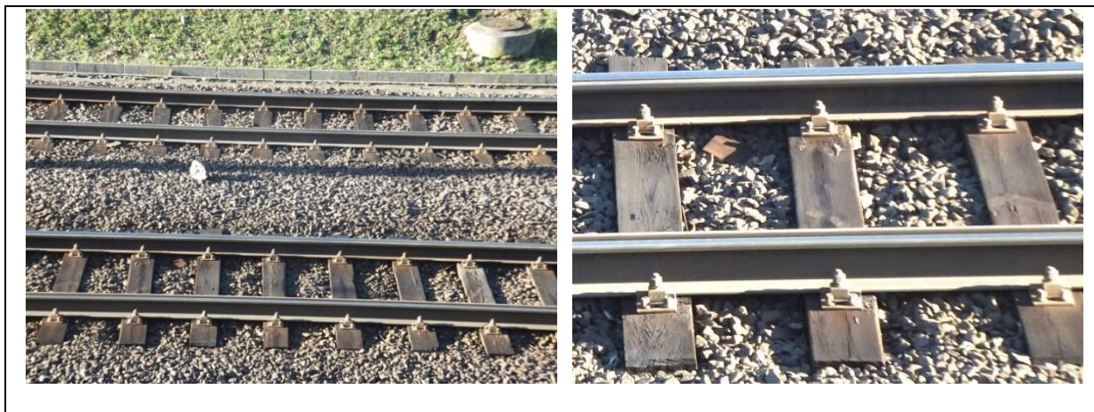
Rys. 3 Torowisko tramwajowe o sztywnym mocowaniu szyn bezстыkowych, podkładach drewnianych i podsypce (materiały własne)
