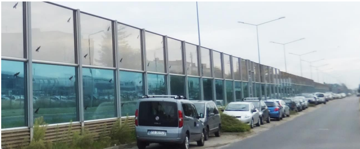
Rys. 14 Ekran przeciwhałasowy odbijający zbudowany z szkła akrylowego i keramzytobetonu u podstawy (materiały własne)
