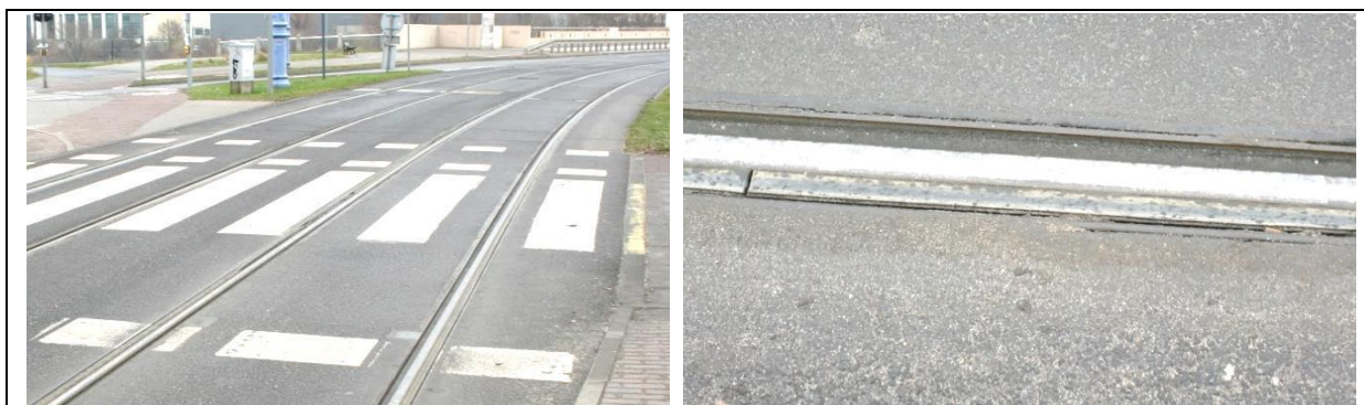
Rys. 7 Torowisko w jezdni z systemem tłumiącym ORTEC (materiały własne)
