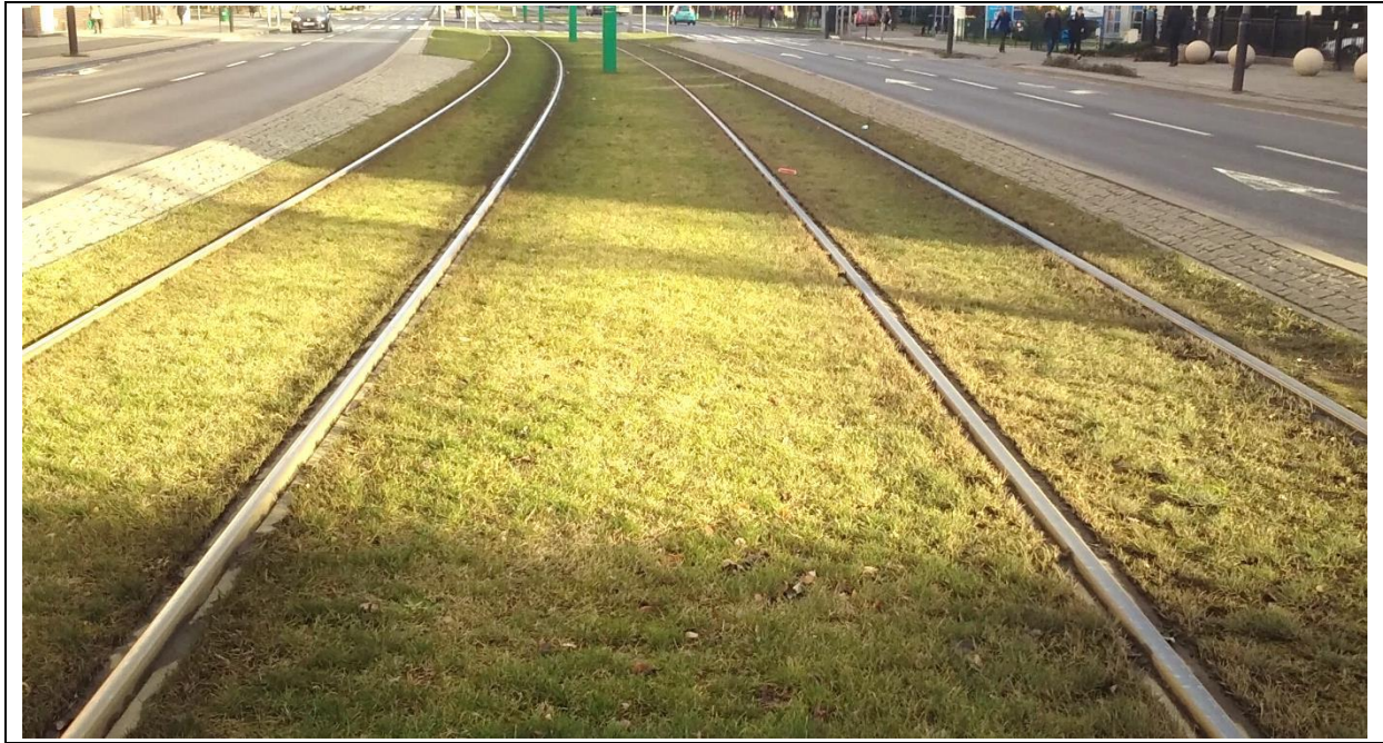
Rys. 5 Zielone torowisko – strunobetonowe torowisko bezstykowe z matami wibroizolacyjnymi w obrębie platform i przejazdów oraz wkładkami w komorach łubkowych (materiały własne)
