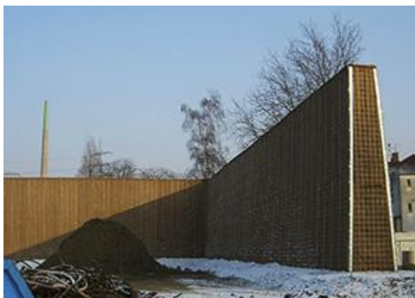
Rysunek 2. Przykładowy ekran akustyczny – ziemny ekran akustyczny z konstrukcją stalową. [Źródło: Ecotec Polska]
