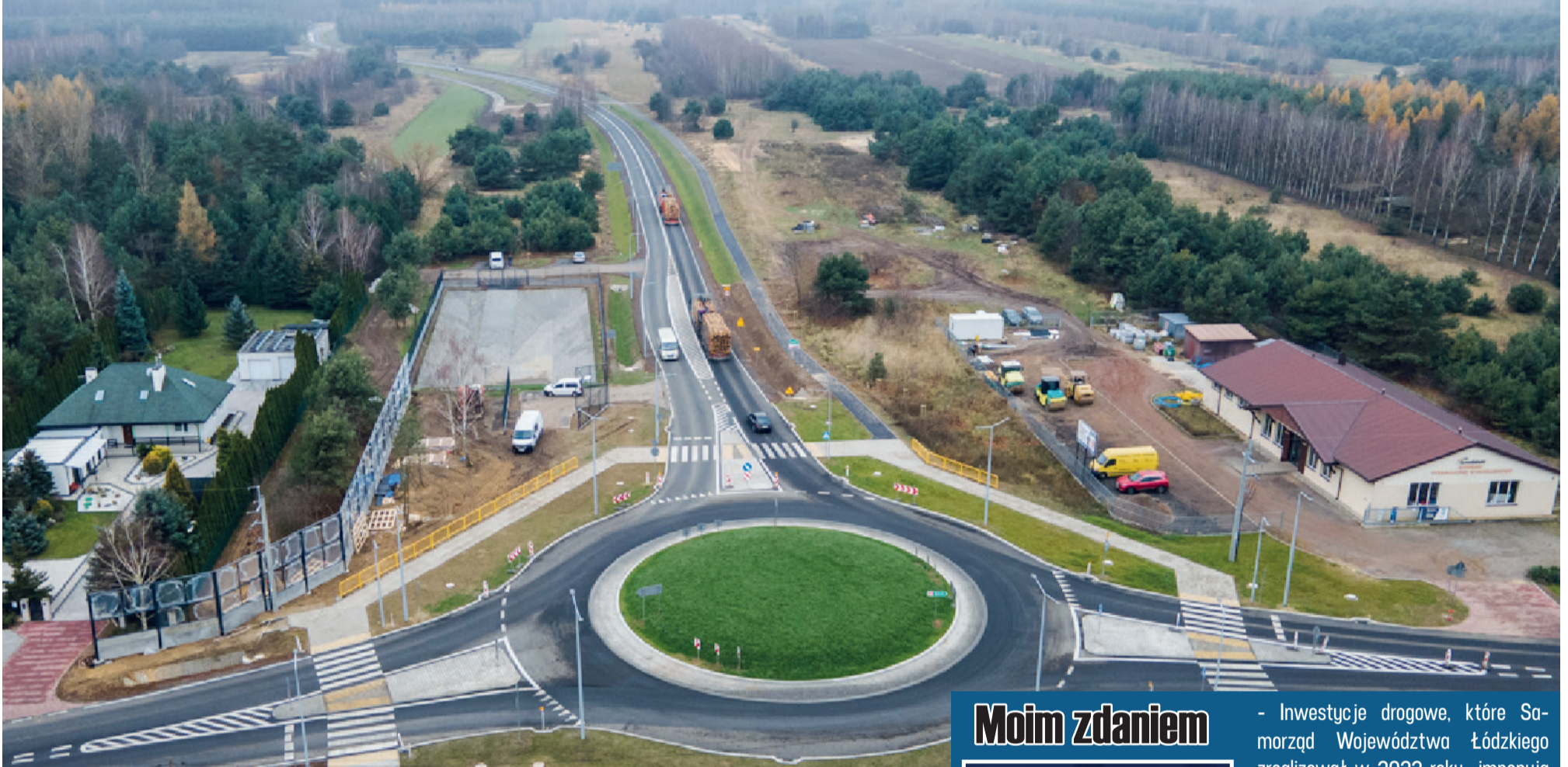
Obwodnica Pragi w ciągu drogi wojewódzkiej nr 703. Budowa liczącej 1,35 km drogi kosztowała 11,5 mln zł. Pieniądze pochodziły m.in. z budżetu województwa oraz z Rządowego Funduszu Rozwoju Dróg
