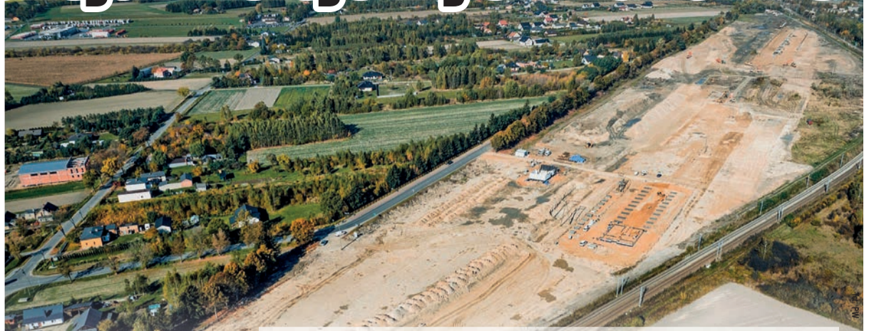
Budowa terminalu już trwa. Całkowita wartość inwestycji to prawie 128 mln 600 tys. zł
