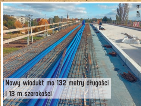
Technologia budowy umożliwia utrzymanie ciągłości ruchu kolejowego pod obiektem
