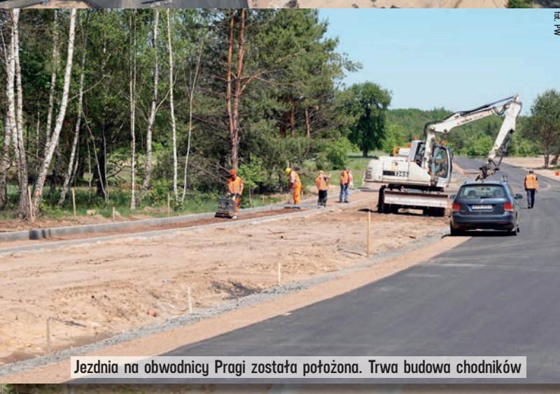
Dzięki nowej drodze ciężkie samochody nie będą przejeżdżać przez Pragę
