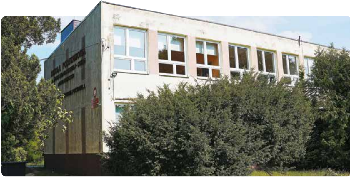
Dzięki wsparciu z Rządowego Funduszu Inwestycji Lokalnych przy szkole w Pawlikowicach powstanie nowoczesna sala gimnastyczna
