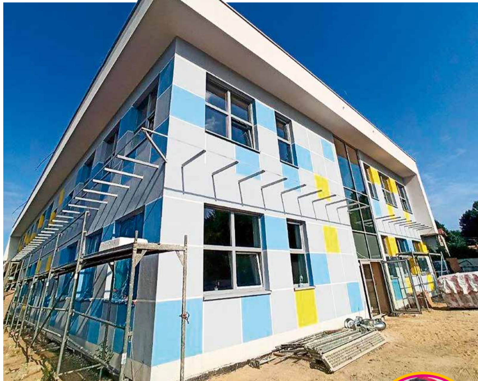
W budynku przedszkola zainstalowano już stolarkę okienną, położona została elewacja
