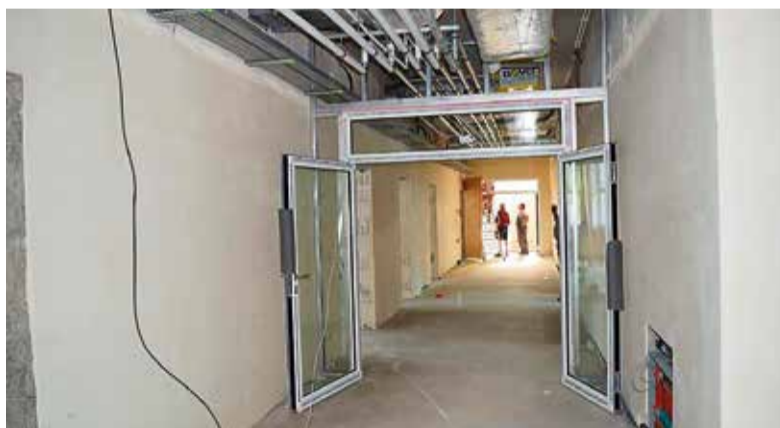
Trwają prace związane z instalacjami wewnętrznymi i montażem ścianek
