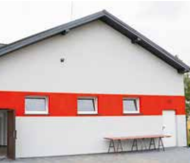
Tak po remoncie wygląda budynek Gminnego Domu Kultury
