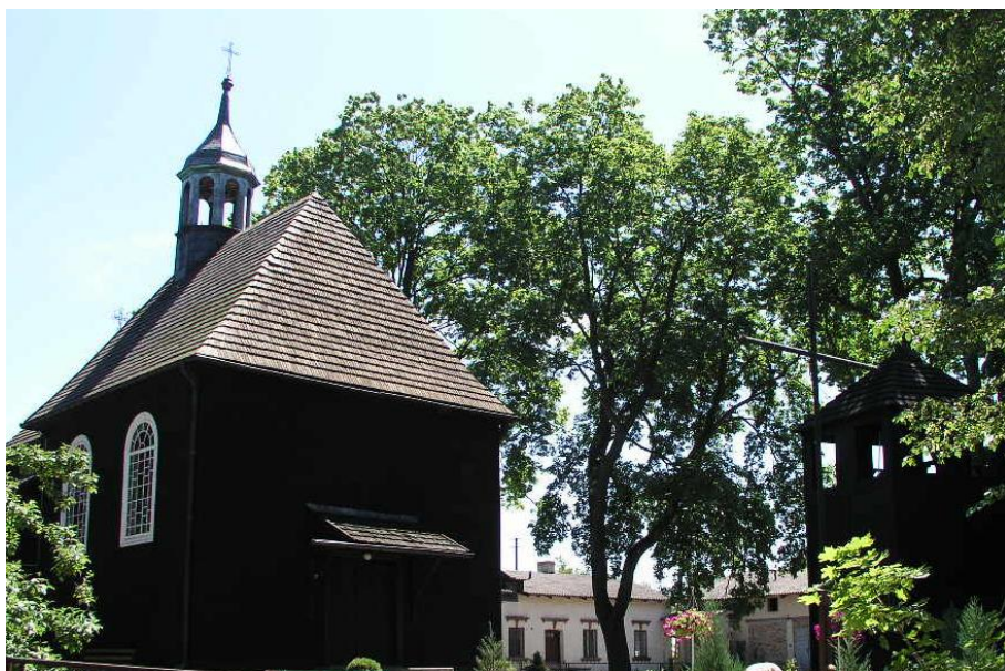
Zabezpieczony od włamań i pożarów kościoł w Rychłocicach
