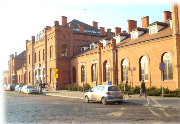
Remont kapitalny peronu w Skierniewicach
