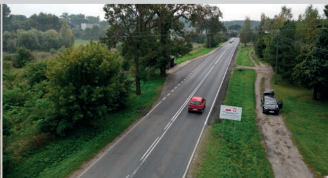
Nowa nakładka asfaltowa na drodze wojewódzkiej 482 między Dębątką a Zapolem w powiecie sieradzkim
