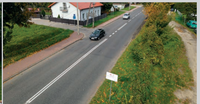
Odnowiona droga wojewódzka nr 707 w Rawie Mazowieckiej
