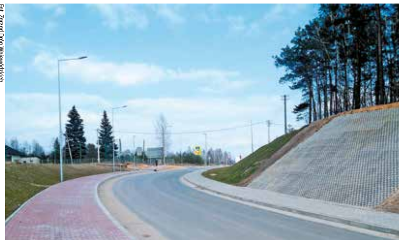
Wyremontowana droga wojewódzka nr 726 łącząca zagłębie ceramiczne w Opocznie z wjazdem na drogę ekspresową S8 w Rawie Mazowieckiej
