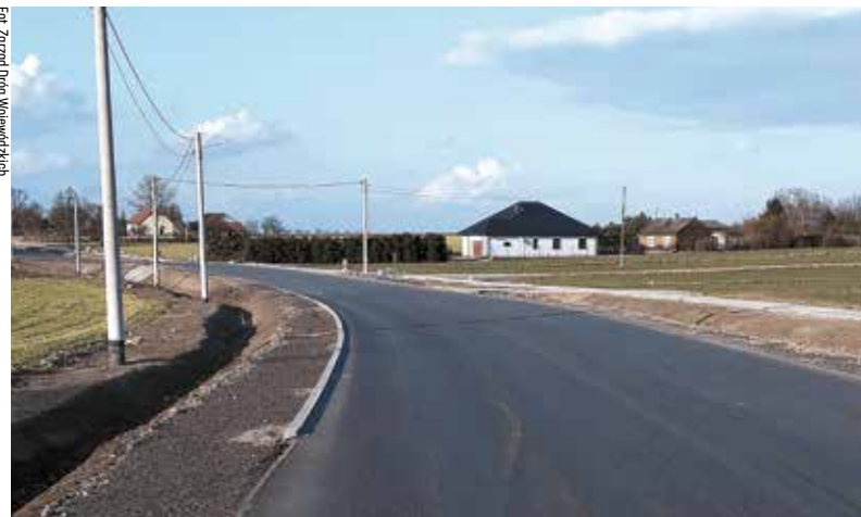
Droga biegnąca przez gminę Sulmierzyce po remoncie
