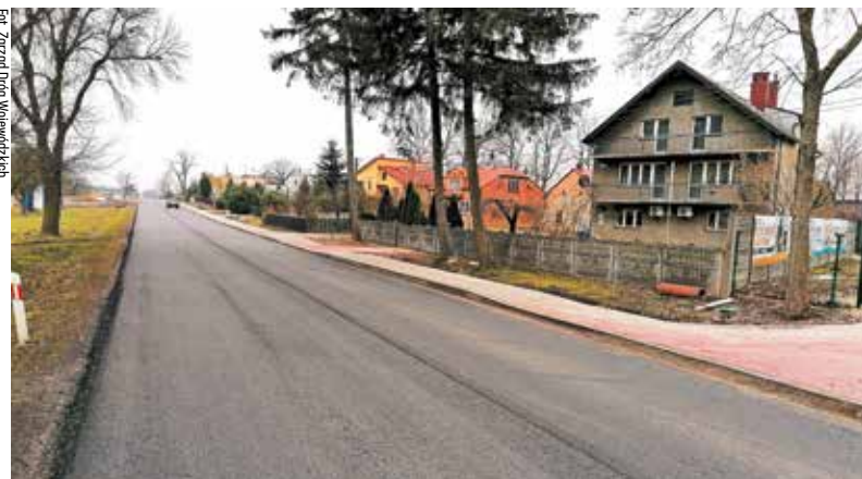
Mieszkańcy Próby po przebudowie drogi wojewódzkiej nr 482 cieszą się z szerokiego chodnika
