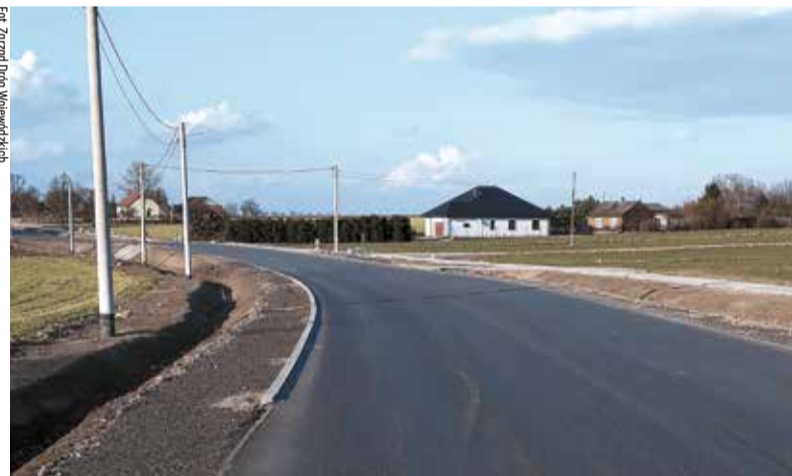
Droga biegnąca przez gminę Sulmierzyce po remoncie
