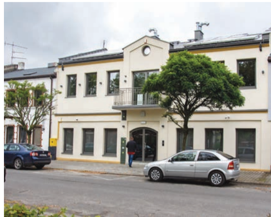
Przebudowa kamienicy przy placu Wolności 10 zakończyła pierwszy etap rewitalizacji
