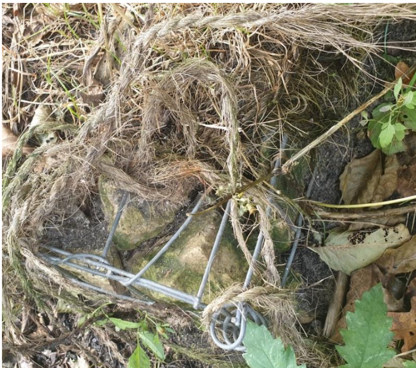
Rysunek 8 Filtr geochemiczny eliminacja związków biogenicznych w strukturze geochemicznej ( podwodna strefa gabionowa z wypełnieniem dolomitowo-wapiennym z matą kokosową)
