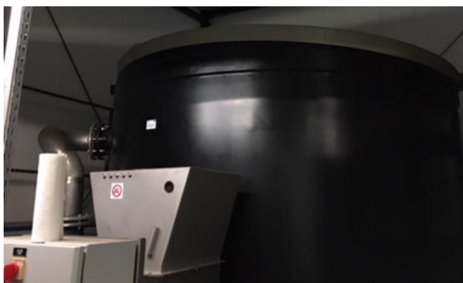
Rysunek 5 Zbiornik uśredniający, Janis
