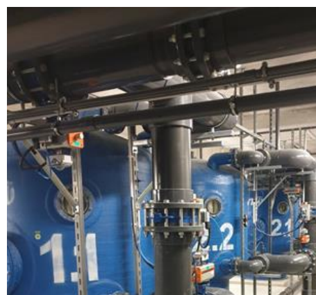
Rysunek 14 Zbiornik w podbaseniu, do którego sphywa woda z rynien przelewowych w Zatoce Sportu
