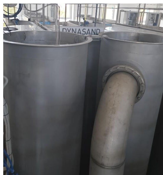
Rysunek 15 Uzdatnianie wody w MPWiK w Sieradzu, filtry DynaSand
