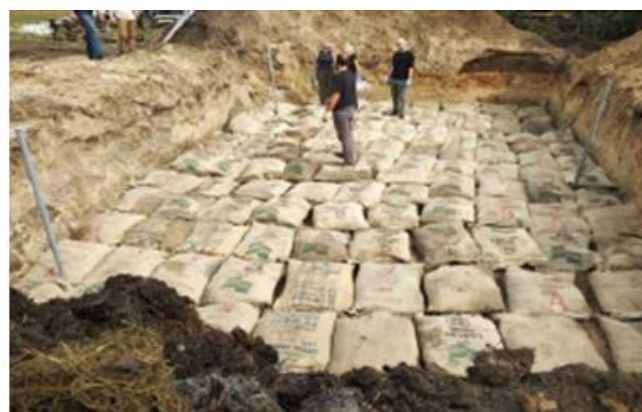
Rysunek 19 Złoże horyzontalne z substratem węglowym zbudowane z modułów
