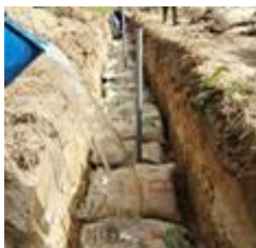
Rysunek 20 Złoże wertykalne na drodze spływu odcieków ze składowiska obornika
