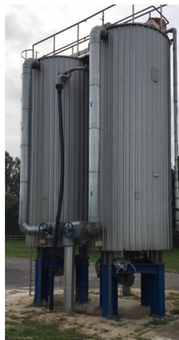
Rysunek 17 Pompy wody technologicznej
