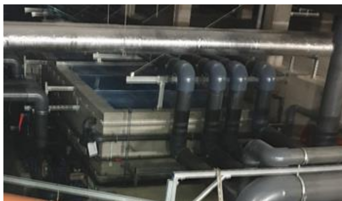
Rysunek 14 Zbiornik w podbaseniu, do którego sphywa woda z rynien przelewowych w Zatoce Sportu
