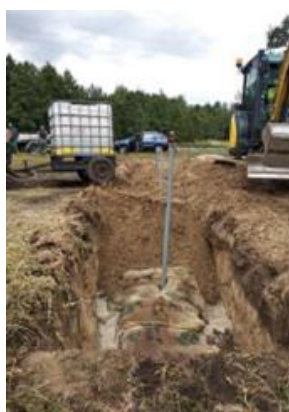
Rysunek 19 Złoże horyzontalne z substratem węglowym zbudowane z modułów
